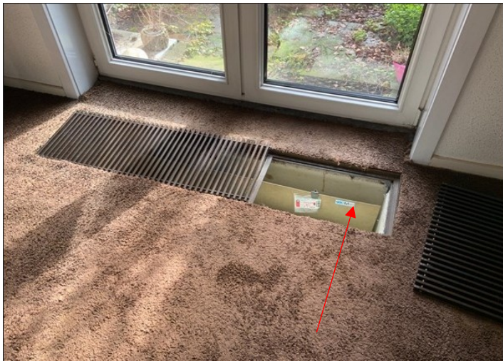
Plaatmateriaal in convectorput
