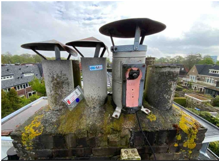
Buizen op schoorsteen
