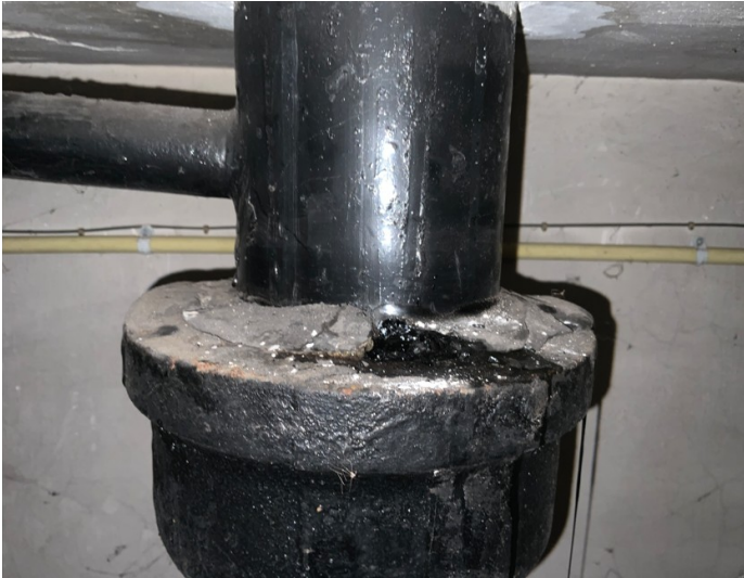
Bitumen afdichting Gietijzeren riolerings moffen
