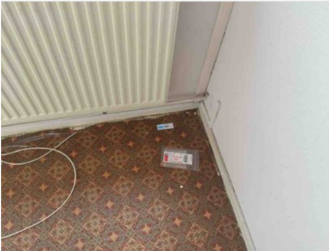
Vloerzeil verlijmd op dekvloer
